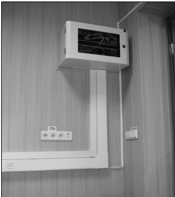
Рис. 1.3. Нормальная коммутация кабелей и размещение оборудования
